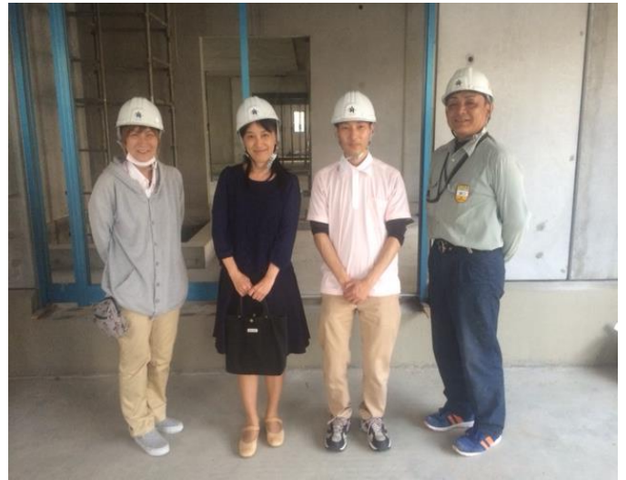
▲上棟間近の看多機等複合施設のエントランス部分で
